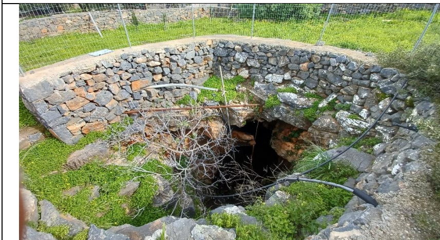
Φωτ. 11 Χ.Θ. 0+398 (Τμήμα Z- Θ). Είσοδος καρπικού εγκοίλου σε πλακώδεις ασβεστόλιθοι (Jm-Es.k1). βρίσκεται σε σχετικά μικρή απόσταση ανάντη (αριστερά) της οδού.
