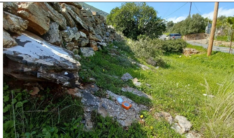
Φωτ. 6 Χ.Θ. 0+000 (τμήμα Δ - Ε). Πλακώδεις ασβεστόλιθοι(Jm-Es.k1 ). Η βαθιά γραμμή μικρής λεκάνης απορροής βρίσκεται πλησίον της οδού.
