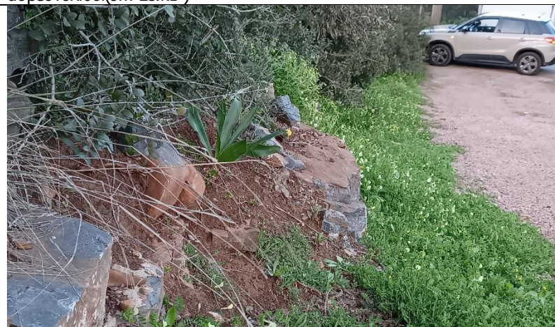
Φωτ. 12 Χ.Θ. 0+529 (Τμήμα Z- Θ). Πλακώδεις ασβεστόλιθοι (Jm-Es.k1)
