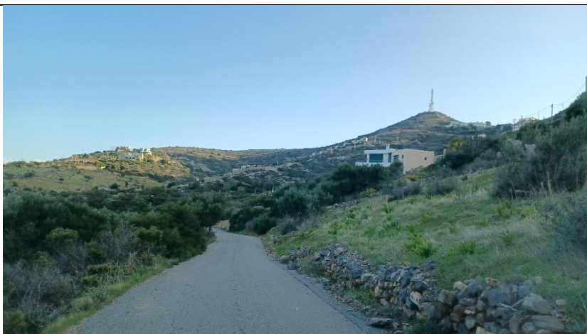
Φωτ. 3 Χ.Θ. 0+615. Χαλαρά εδαφικά υλικά επάνω από πλακώδεις ασβεστολίθους. Η διάβρωση των χαλαρών υλικών ελέγχεται από αναβαθμίδες από ξερολιθιά.
