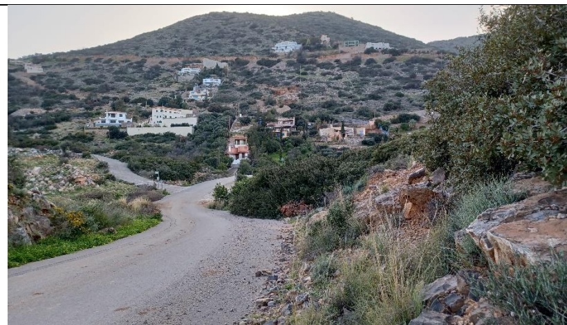
Φωτ. 2 ΧΘ 0+321 .Πλακώδεις ασβεστόλιθοι δομούν την περιοχή. Στο χαμηλότερο σημείο της εικόνας, βρίσκεται ο χείμαρρος, η θέση του οποίου σχετίζεται με το ρήγμα P1-IGME.
