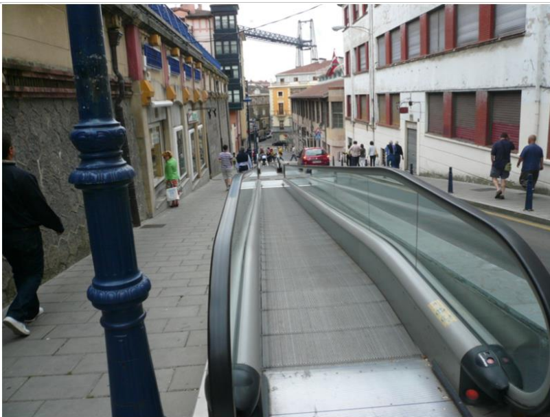
Εικόνα 36: Κυλόμενος διάδρομος για ΑΜΕΑ
