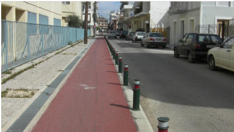
Εικόνα 30: Παραδείγματα αποκλειστικής υποδομής ποδηλάτου με υπερύψωση σε σχέση με το οδόστρωμα.
