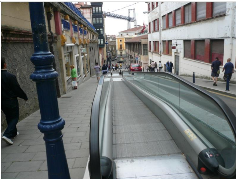
Εικόνα 36: Κυλιόμενος διάδρομος για ΑΜΕΑ
