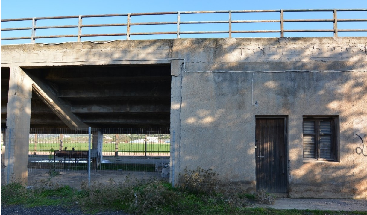
Φωτογραφία 6: Αποκόλληση της τοιχοποιίας στα ψηλότερα σημεία της, γύρω από το επίπεδο υποστυλωμάτων – δοκών που την πλαισιώνουν.
