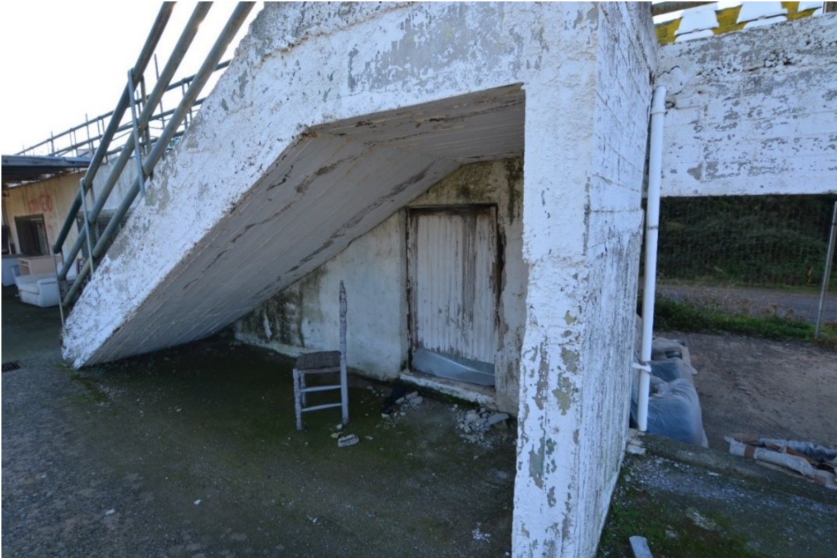
Φωτογραφία 5: Το κτίριο κερκίδων με εμφανείς φθορές στα επιχρίσματα.
