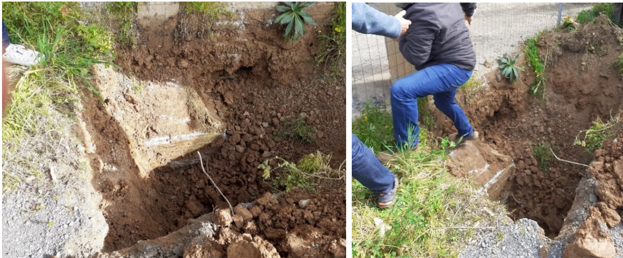
Φωτογραφία 8,9 : Το υφιστάμενο πέδιλο των στύλων του κτιρίου κερκίδων.
