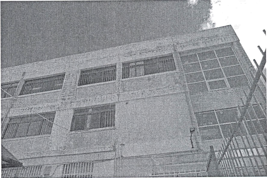
Φωτ. Γ.1: Όψη βορεινή Λυκείου
